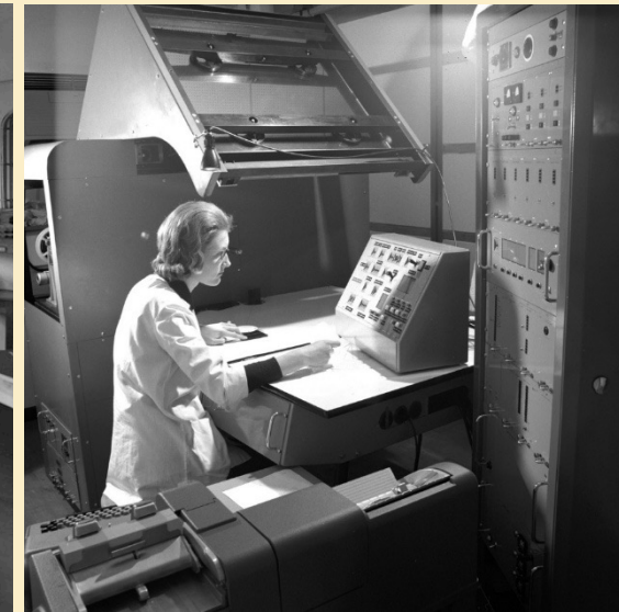
Mesa de scanning Milady para analizar fotografías de cámara de burbujas. 8/3/1963 CERN
